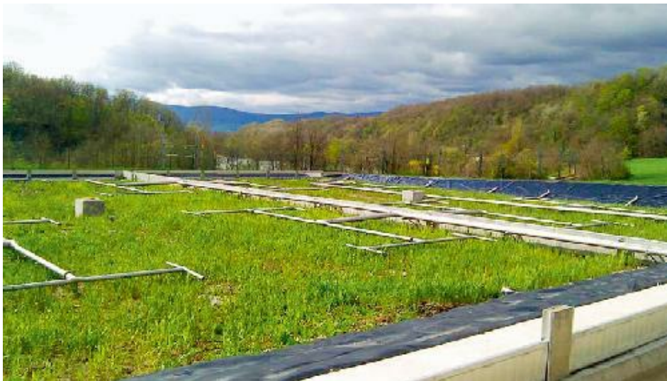
位于法国沙莱克斯市的垂直潜流湿地，为约2000名居民提供污水净化服务。
